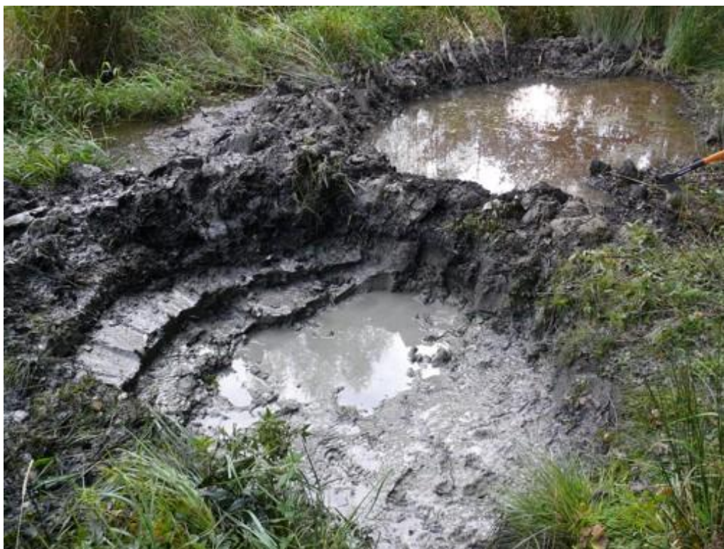
Vždy se snažíme o vytvoření mělkých litorálních partií u okrajů nádrží. Ty mohou být kontinuálně se svazující nebo etážové jako na tomto snímku.
