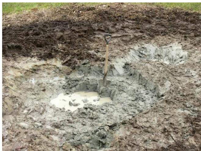
Nejrychlejší a nejefektivnější způsob ručního výkopu tůň je systematické etážové „odkrajování“ těžené zeminy.
