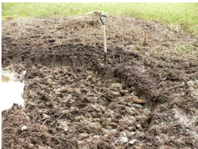
Nejrychlejší a nejefektivnější způsob ručního výkopu tůň je systematické etážové „odkrajování“ těžené zeminy.
